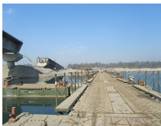
写真29 2013年は仮の橋ができ車で対岸へ
