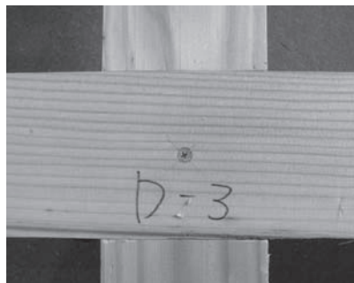
e) 脱落防止のためのビス止め
