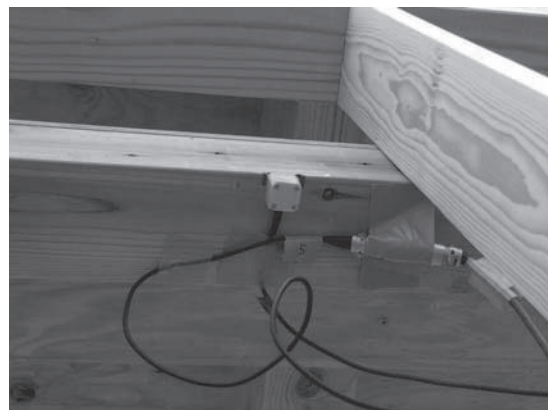
f) 加速度計の取付け
