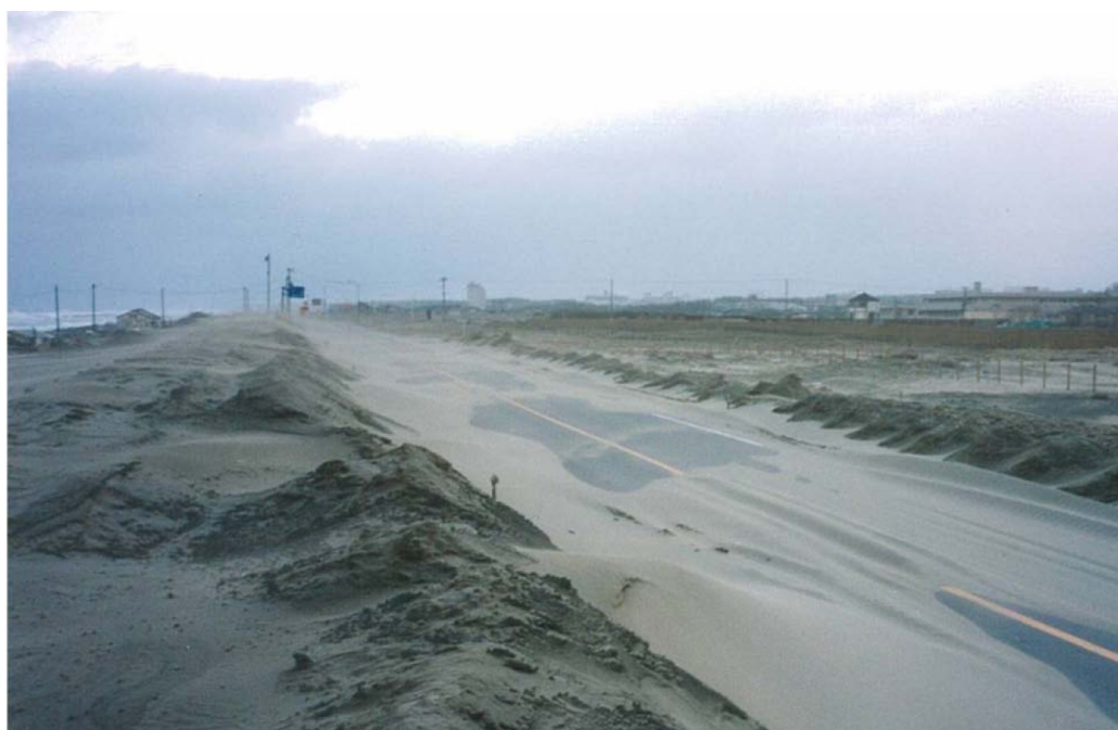
図-1.1 海岸道路の飛砂の堆積（新潟県 新潟海岸の例）
