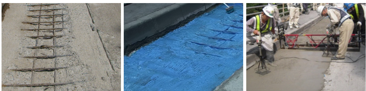
(1) 脆弱部除去 (2) 接着剤の塗布 (3) 補修
