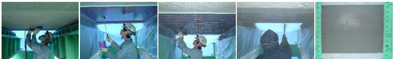
(1) 切削・研掃 (2) 接着剤塗布 (3) CFRP 格子筋配置 (4) モルタル吹き付け (5) こて仕上げ
