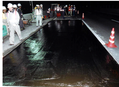
写真－2.6 塗膜系防水工
