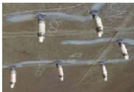
写真－ 2.4 ひび割れ注入工法の事例 2.7)
