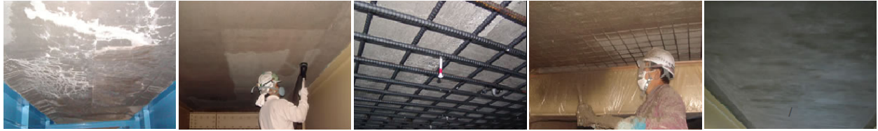
(1) 損傷状況 (2) 下地処理 (3) 補強鉄筋配置 (4) モルタル吹き付け (5) 完成
