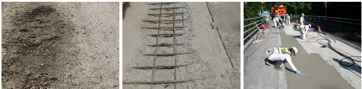
(1) 上面劣化 (2) 脆弱部除去 (3) 補修
