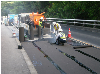
写真－2.5 シート系床版防水工
