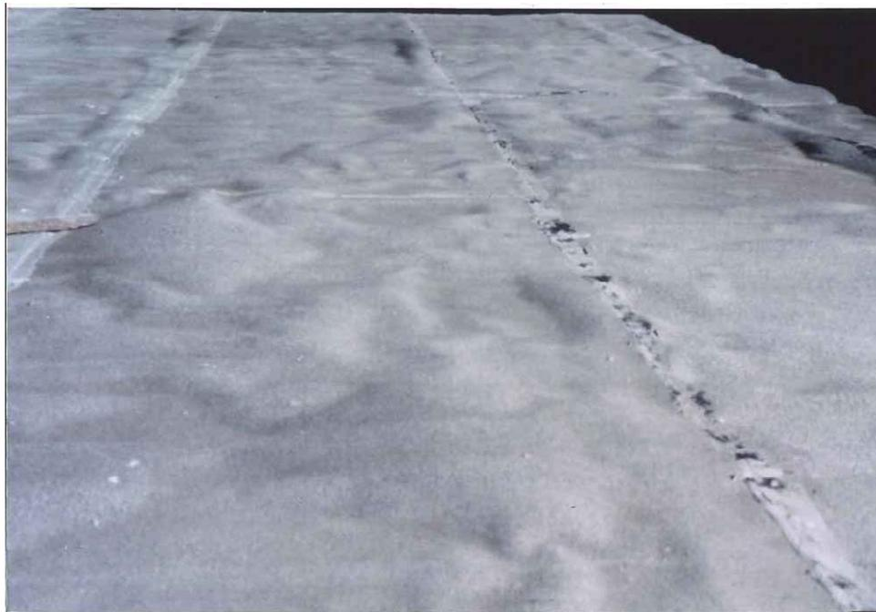
写真 5-28 屋上(防水層) アスファルトシートの下に残った水分が膨張して、防水層を破った(雨天時の作業が原因) 著者撮影
