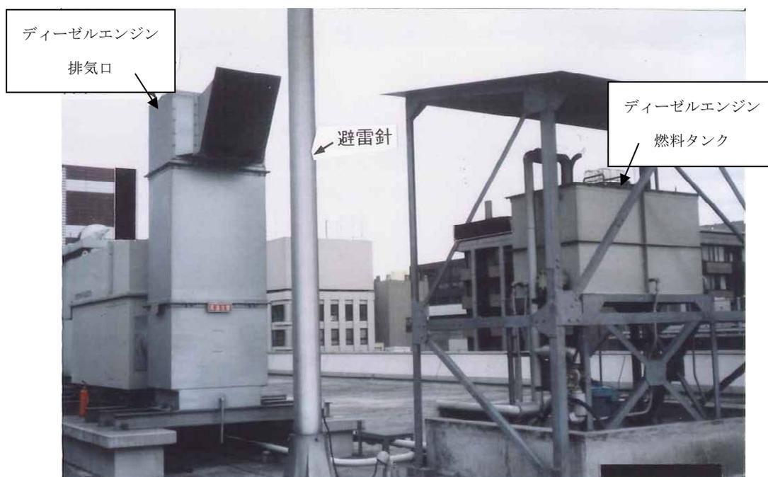
写真 5-19 屋上 排気口の直前に燃料タンクが配置されている
