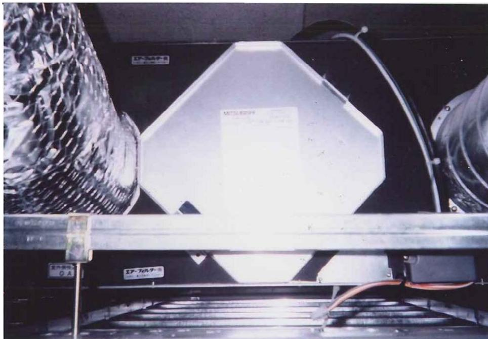
写真 5-15-① 空調機(天井内) 天井下地が当たって、部品の取り出しができない
