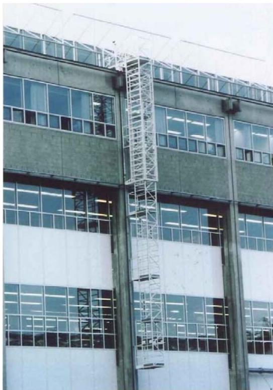
写真 5-37(良い事例) 外壁(窓面) 上下左右に移動できる足場を常設してある
