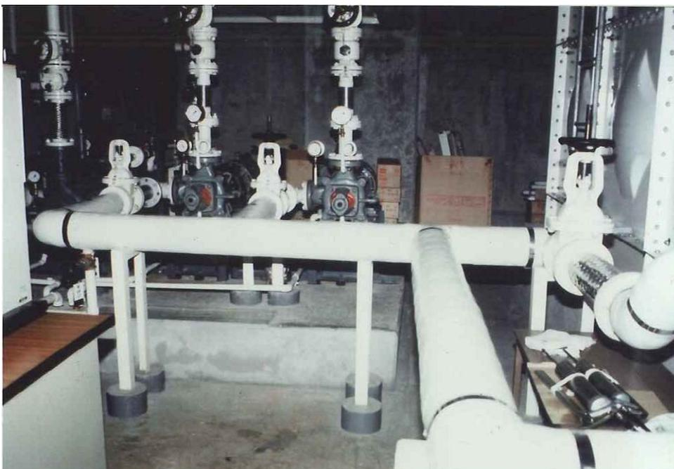
写真 5-23 配管 配管の設置された高さが中途半端で作業が難しい
