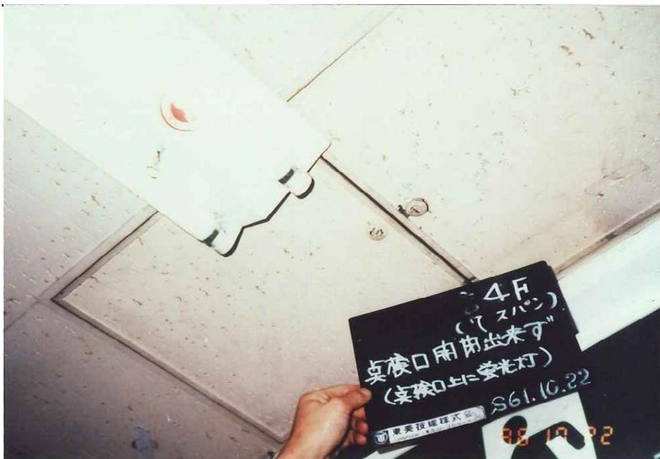
写真 5-21 照明器具(天井) 点検口の上に照明器具を設置点検口が使用不可能
