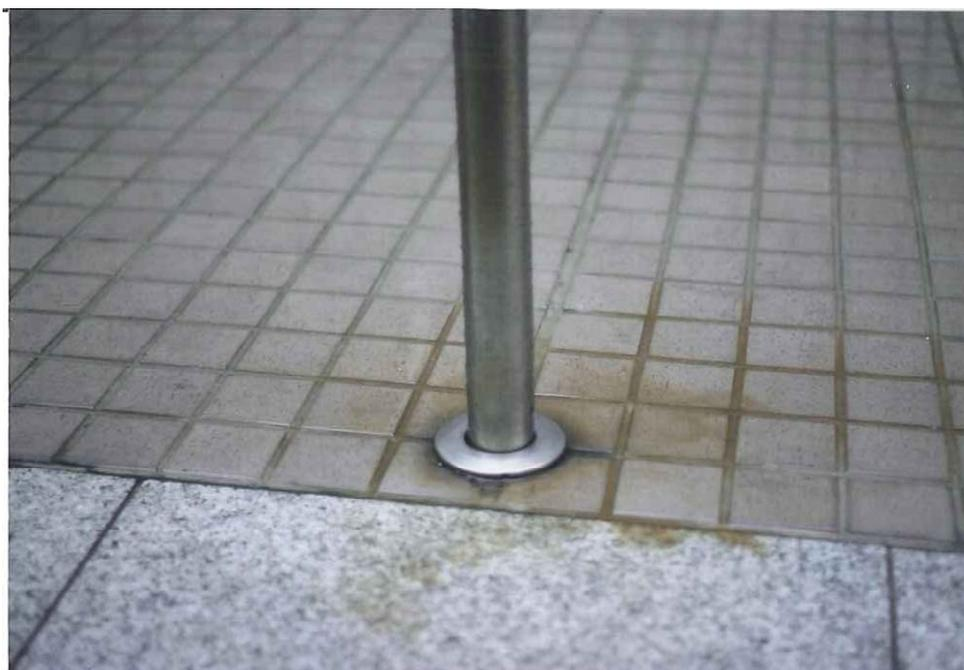
写真 5-32 駐車場(ポール) ポールの下部のケース(鉄製)に水抜き穴がなく、
