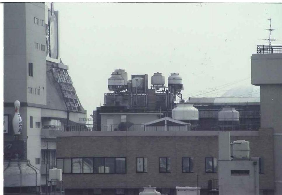
写真 5-17 屋上(塔屋)クーリングタワーが並べて設置されているが安全柵がない
