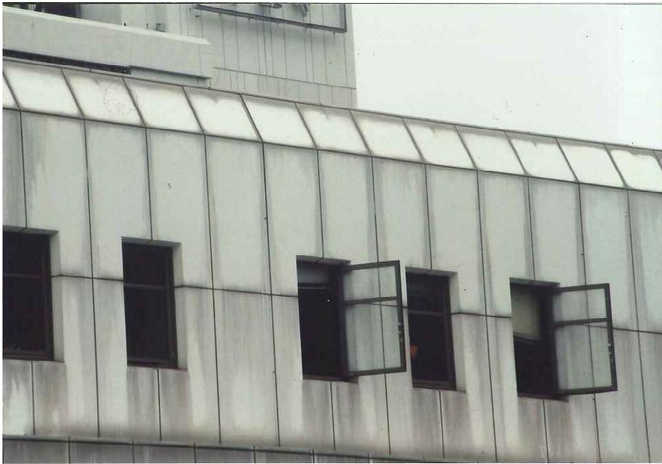
写真 5-1 外壁 雨仕舞、水切りが不良で汚損 著者撮影
