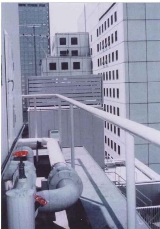
写真 5-18 屋上 外周ぎりぎりに設置された機器・配管
