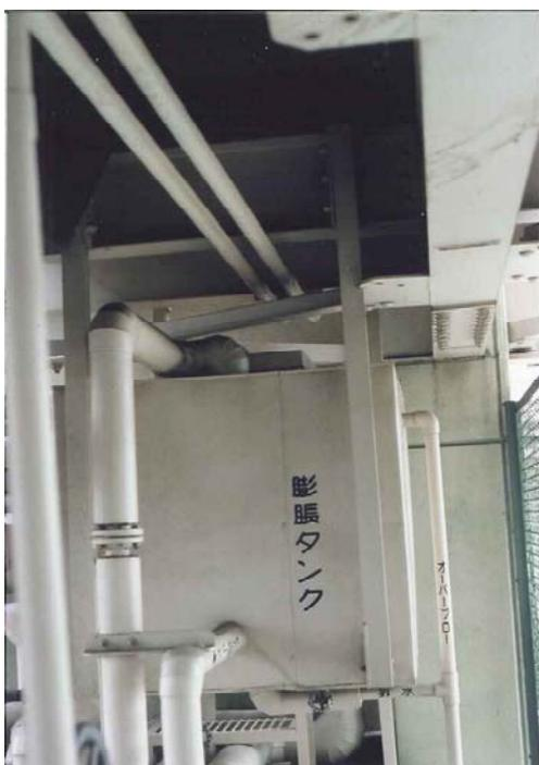
写真 5-12 膨張タンク 上部の点検口の上に構造物を設置した為に
