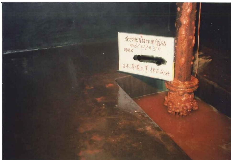
写真 5-16 受水槽 揚水配管の錆びている状況(管理不良)
