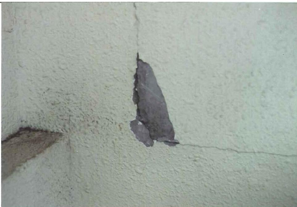
写真 5-31 外壁(階段室) 梁と柱の取合い部分に亀裂. 躯体とブロック壁の間に
