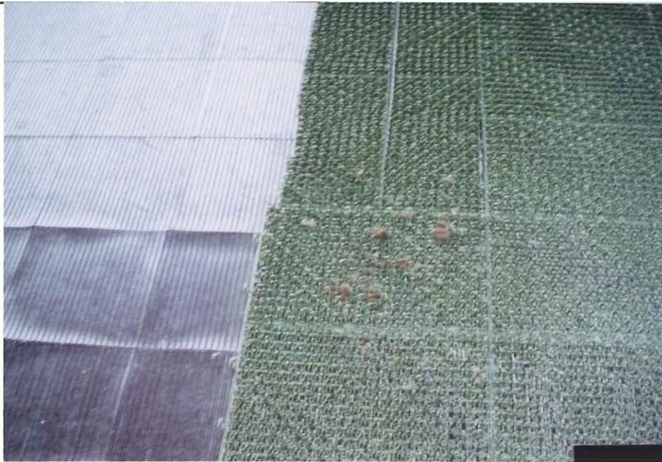
写真 5-30 床面(建材) 冬期に施工した床仕上げ材が夏期に膨張した
