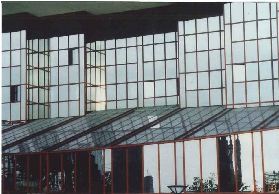
写真 5-3 外装(アトリウム天井) 作業用出入口がなく清掃ができないガラス面
