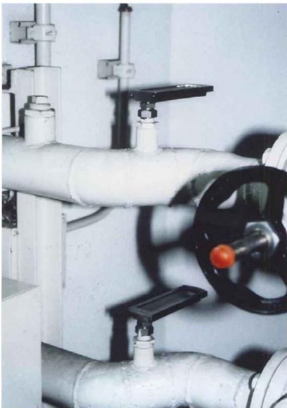
写真 5-22 配管(機器) 上下に全く同じ位置にメータが設置されているため
