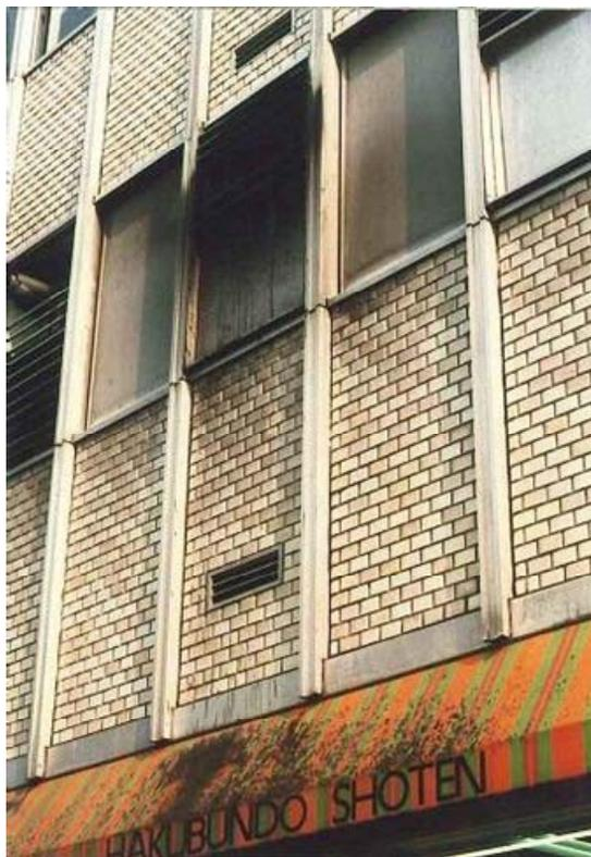
写真 5-2 外壁 厨房の排気対策の不良で汚損 著者撮影
