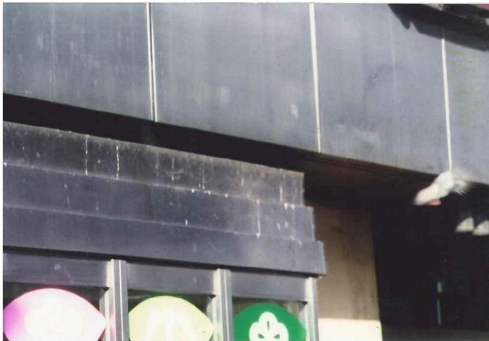
写真 5-5 外装 風除室の上部と2階スパンダレルの間にすき間があり、鳩の巣になっており汚損 著者撮影
