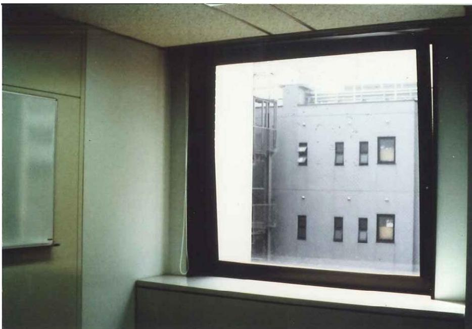
写真 5-39(良い事例) 外壁(窓) 縦方向にも横方向にも開放できる窓,
