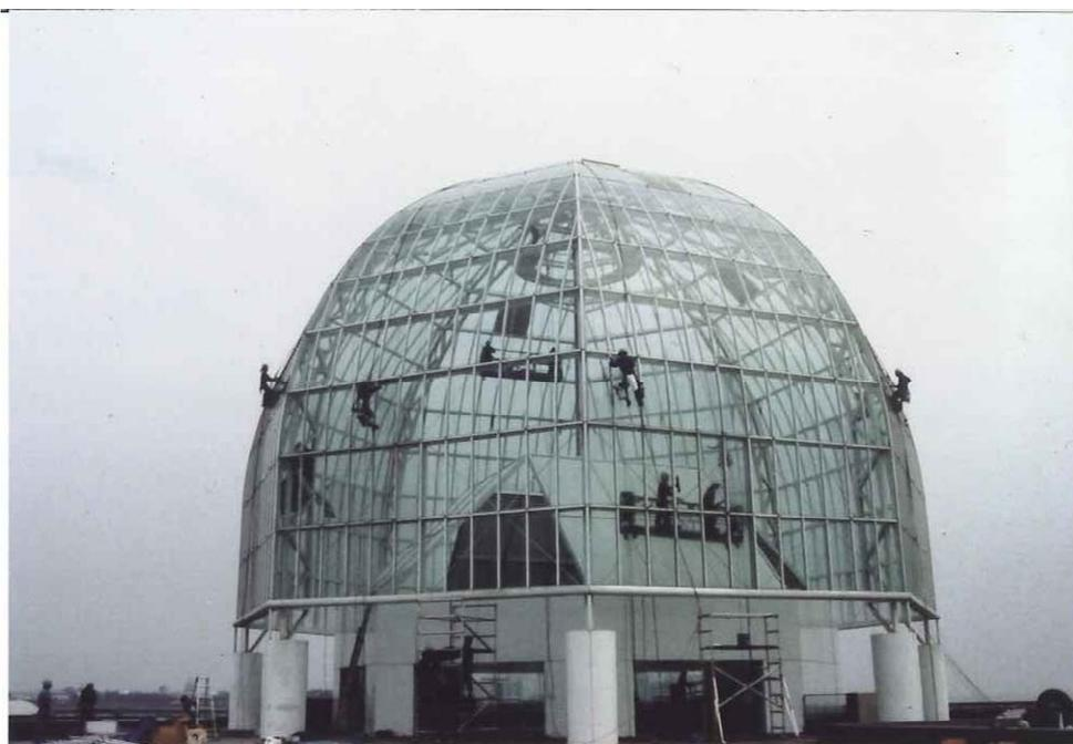
写真 5-6 外装(屋根) 内側・外側に清掃対策がされていないことから清掃費用が増加, 結果として清掃回数が減少
