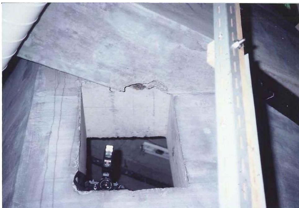
写真 5-24 受水槽室 周囲の壁は出入口がなく、壁面に開けられた点検口
