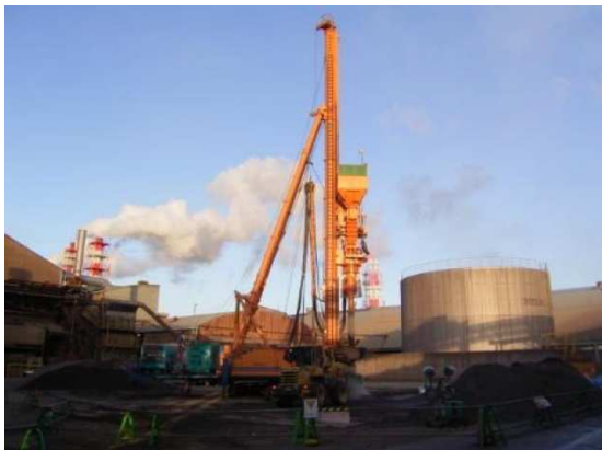
図-2.3.2 フェロニッケルスラグの地盤改良材としての施工実績例
