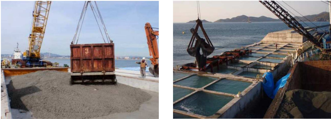
図-2.3.1 非鉄金属スラグのコンクリート材としての施工実績例
