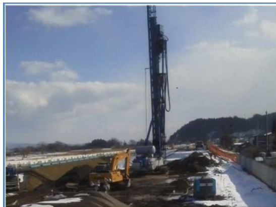
図-2.3.2 フェロニッケルスラグの地盤改良材としての施工実績例
