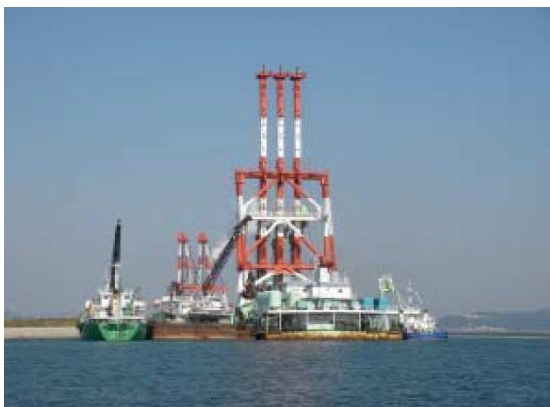
図-2.3.3 銅スラグの地盤改良材としての施工実績例
