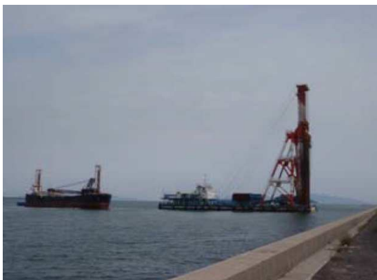
図-2.3.3 銅スラグの地盤改良材としての施工実績例
