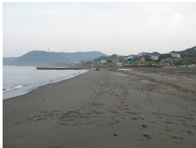
図 2.5.3 離岸堤背後の舌状砂州から北側の突堤を望む
