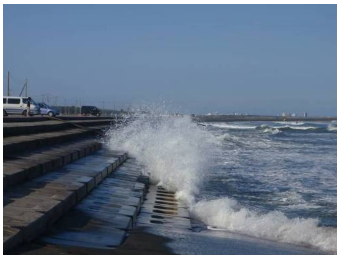
図 1.1.1 千葉県一宮海岸における越波の状況
