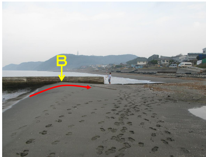
図 2.5.4 突堤の南側側近から北向きに望む
