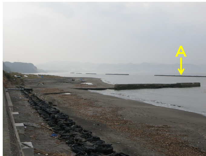
図 2.5.2 離岸堤に隣接する突堤を北側から撮影
